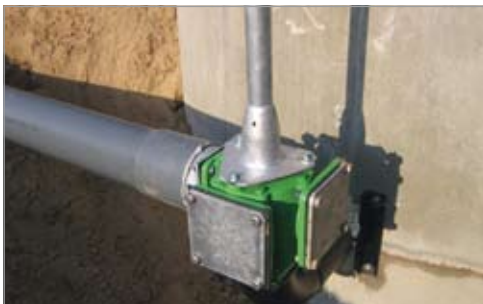
Spülleitungsschieber DN125
